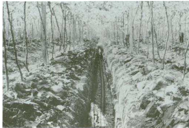
圖 7 葡萄園 設暗管有利排水
